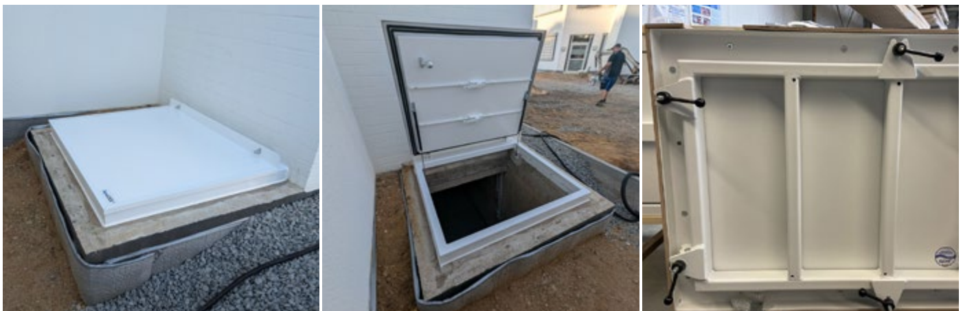
Horizontaal geïnstalleerde klep ter bescherming van een nooduitgang. / Klep ontworpen voor wandmontage.
